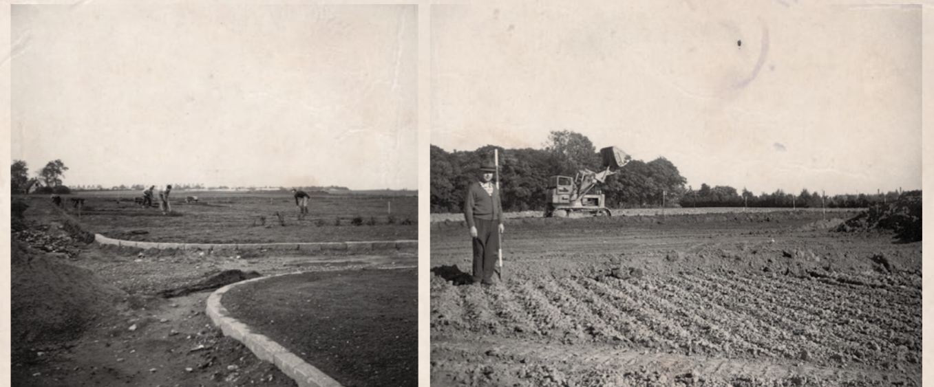
Anlæggelse af veje og jordarbejde.
